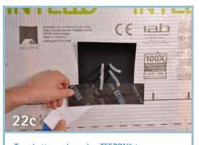
Tape bottom edge using TESCON® tape
